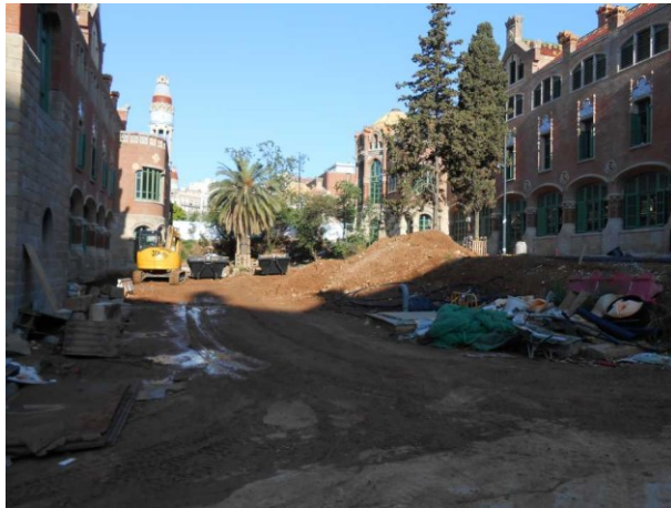
Fotografia 01. Situació inicial entre els pavellons.
