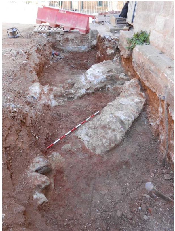
Fotografia 12. Vista general de les estructures UE 114 i 115
