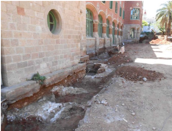
Fotografia 15. Vista general del conjunt d'estructures documentades a costat septentrional del pavelló de Sant Salvador
