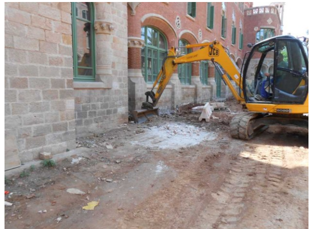
Fotografia 04. Inici de les tasques d'excavació
